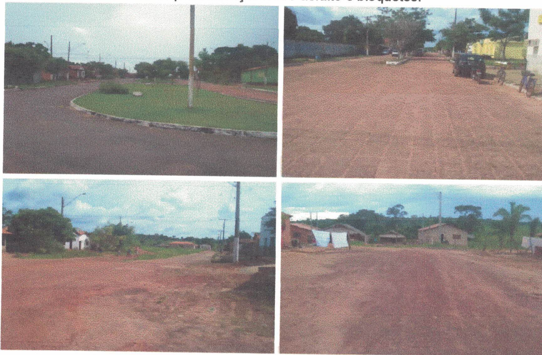
Pavimentação do Sistema Viário da Cidade
